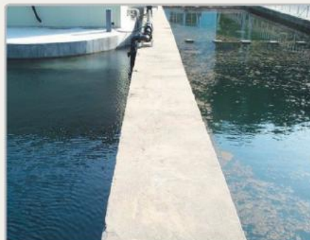
조류 유입시 슬러지 침전효율 저하 및 슬러지부상
